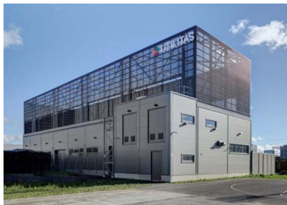
Utilitase uus kaugjahutusjaam
