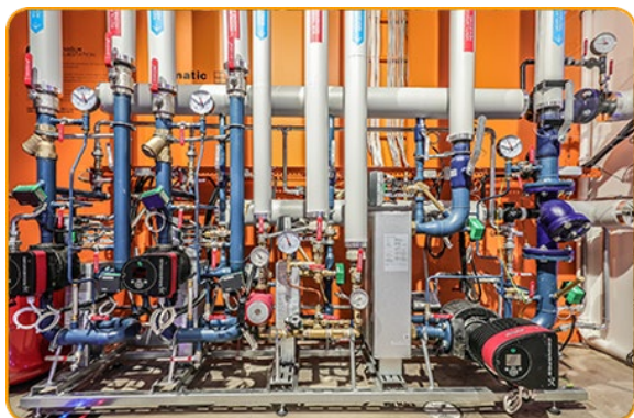
Joonis 2. Soojussõlm
