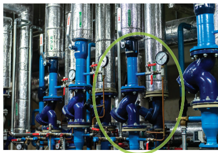
FOTO 11. Impulsstorudega ühendatud manomeeter ning sõelfilter
