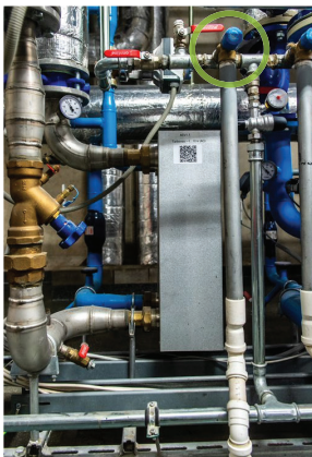
FOTO 14. Sinised ümmarguse käepidemega kaitseklapid märgitud rohelisega
