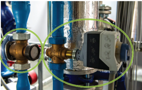
FOTO 2. Pildil on 3-tee ventiil (vasakul), kus üks port on suletud ning 2-tee ventiil (paremal)
