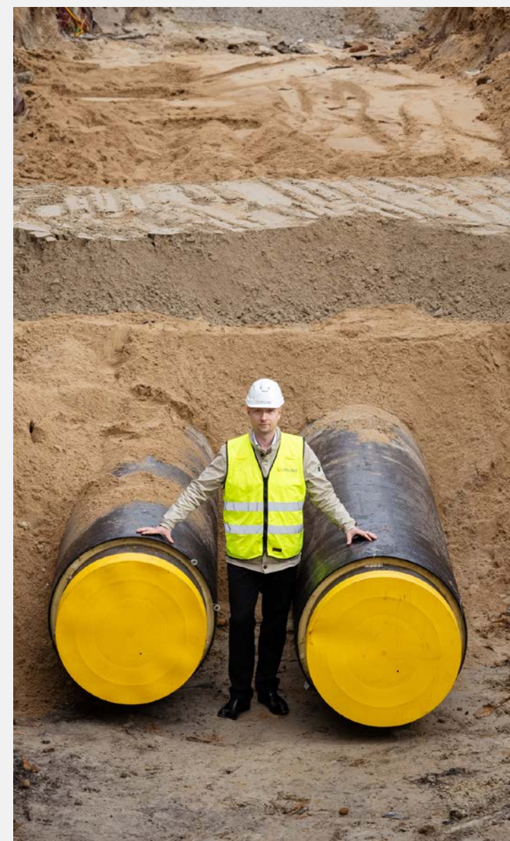
Kaugjahutusvõrgu ehitustööd Tallinnas
